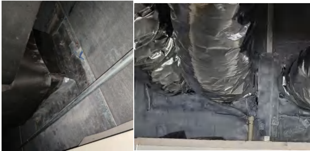
图 3-7 项目机房通风系统现场核查
