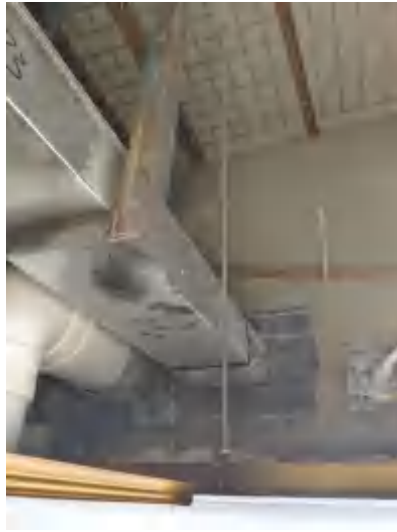
图 3-7 项目机房通风系统现场核查
