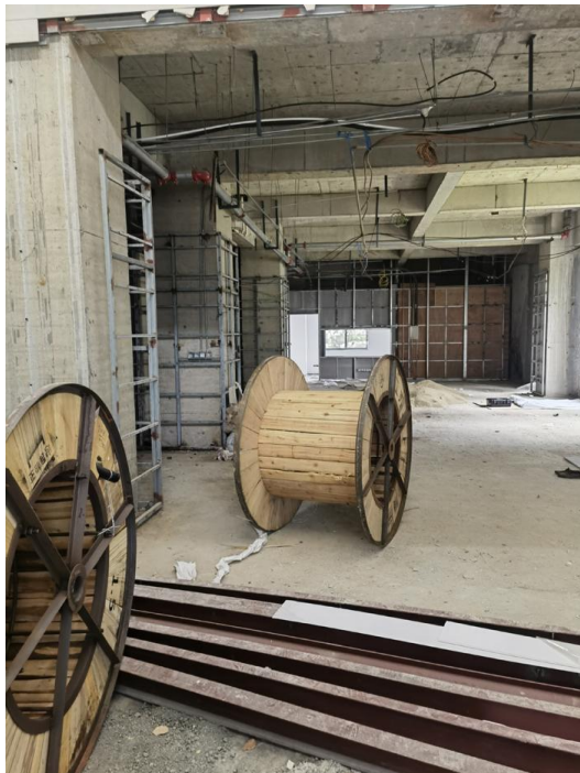
拟改建 DSA 机房区域
