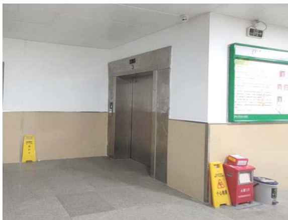
北侧：电梯井、通道
