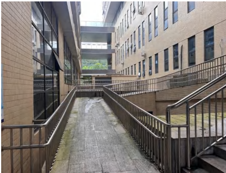
东北侧：室外连廊
