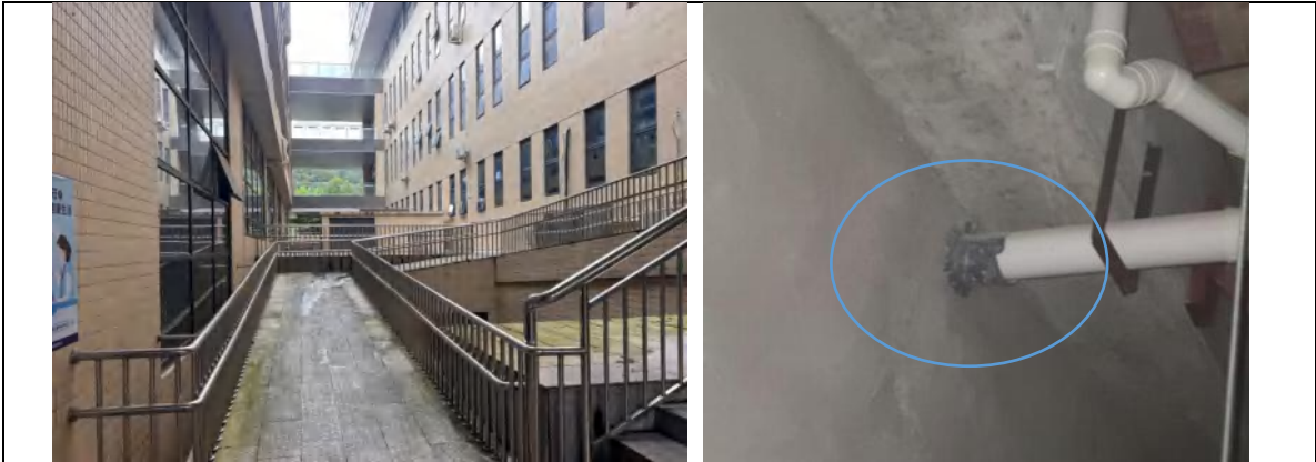
图 3-7 项目机房通风系统和通风管道穿墙补偿防护现场核查
