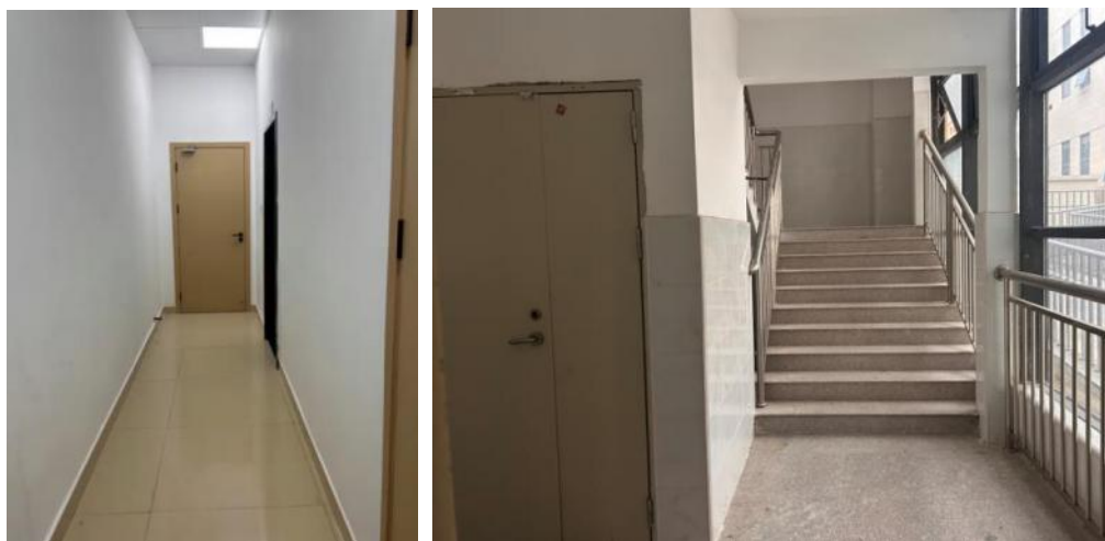
东南侧：楼梯、污物走廊
