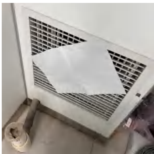
图 3-10 排风口现场核查
