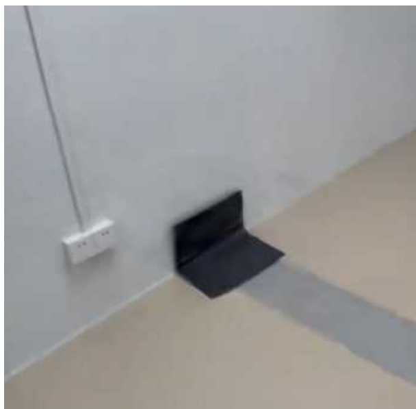
图 3-6 介入科 DSA 机房电缆沟穿墙照片
