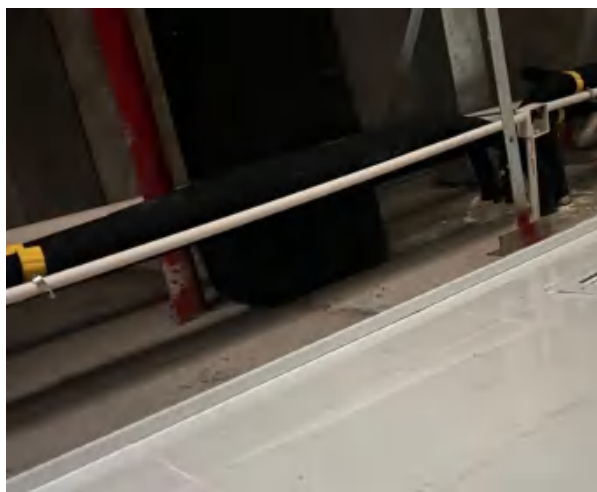
DSA 机房风管穿墙
