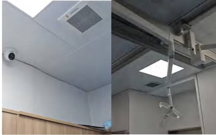
图 3-7 项目机房通风系统现场核查
