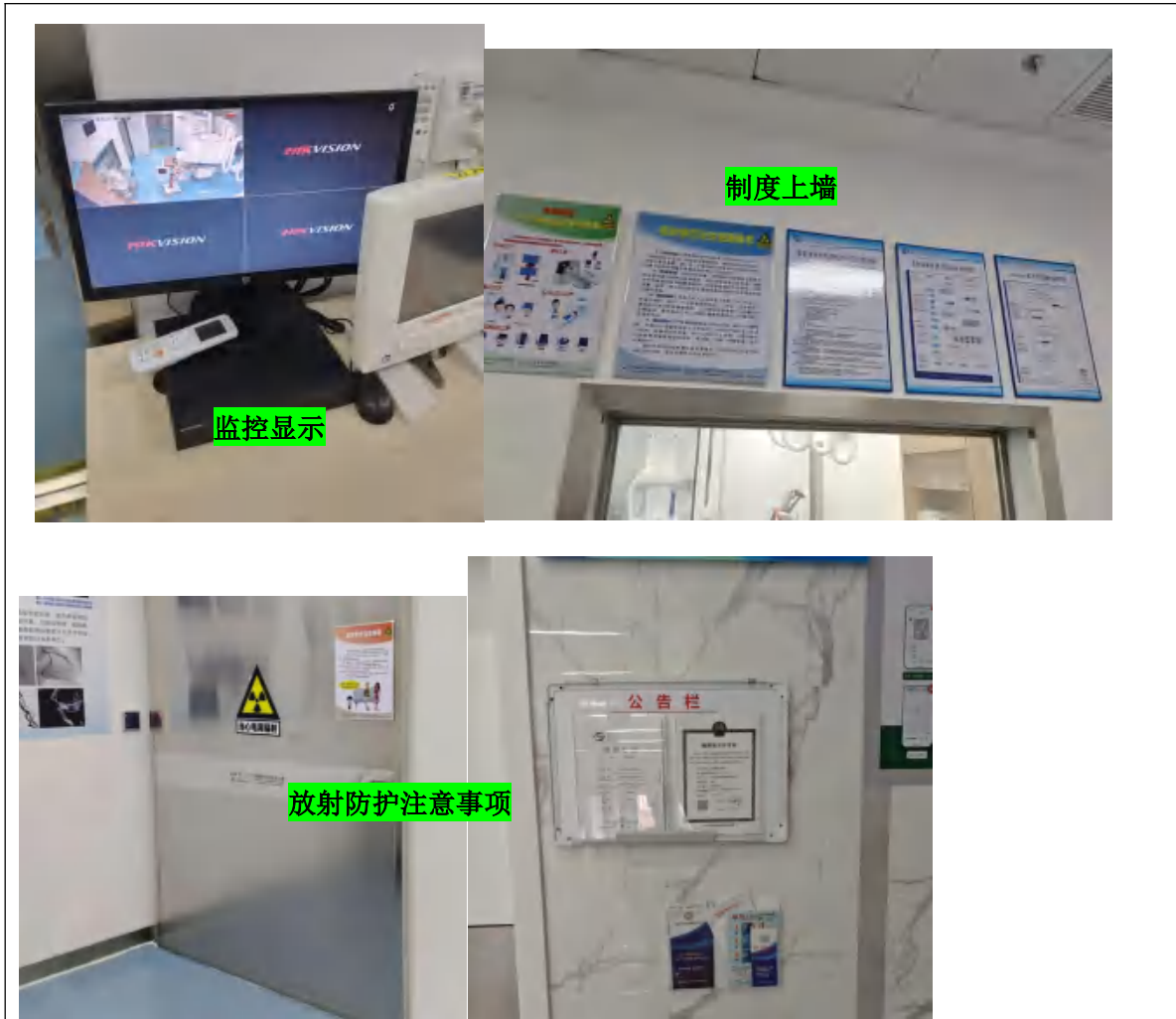
图 3-4 项目机房的联锁装置和警示标志现场核查情况
