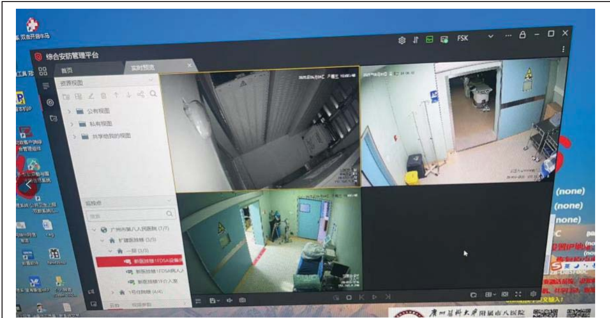
图 3-4 项目机房的联锁装置和警示标志现场核查情况
