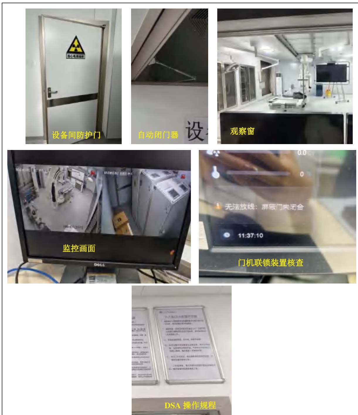
图3-4 辐射防护措施现场调查图
