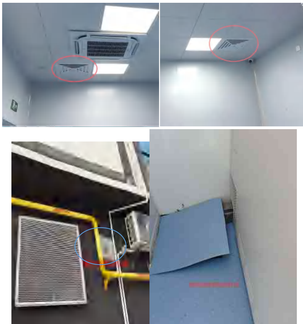
图 3-7 项目机房通风系统和电缆沟穿墙补偿防护现场核查
