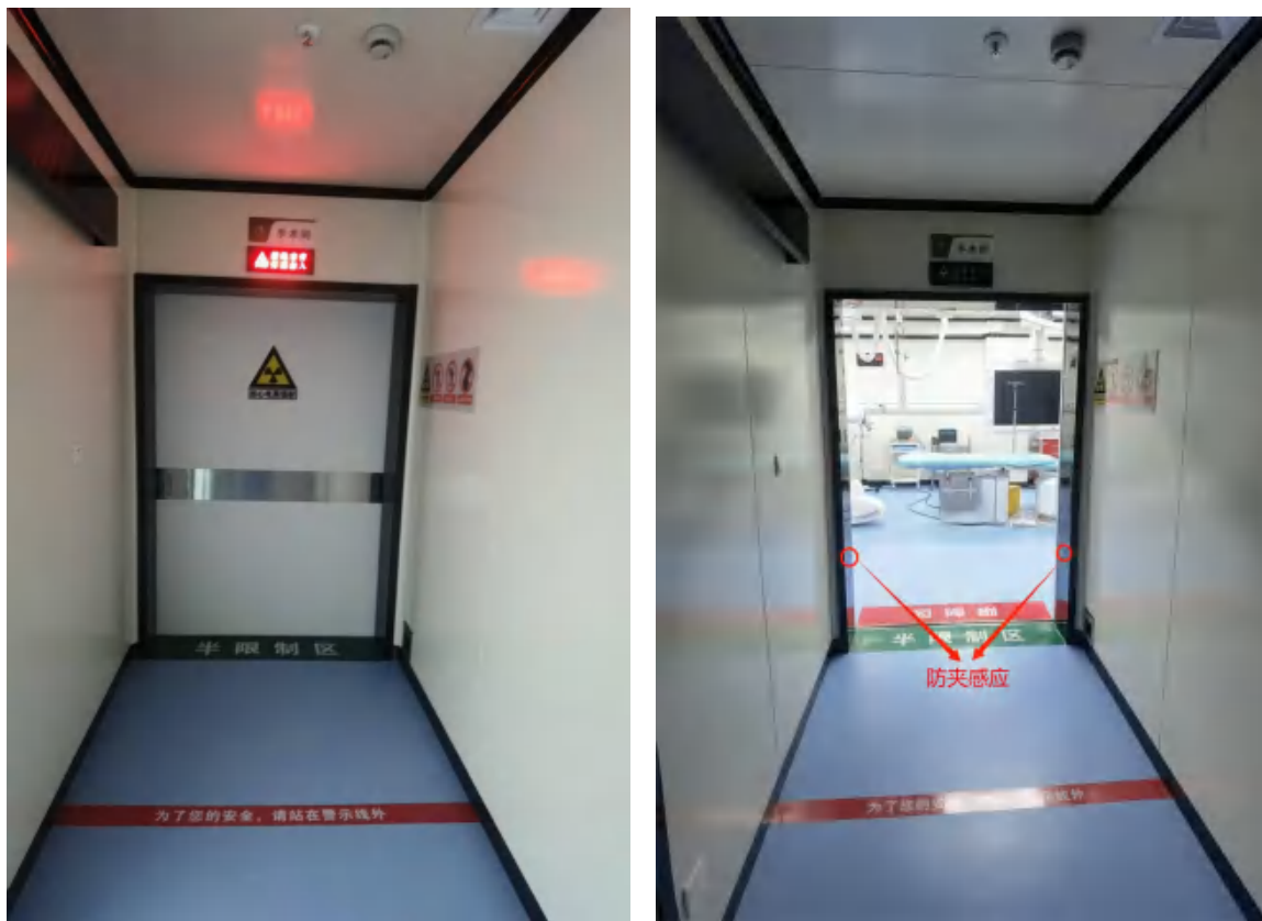
受检者防护门电离辐射警示标志、工作状态指示灯（门关灯亮 门开灯灭）、防夹
