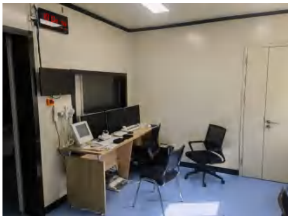
DSA 机房南侧操作室
