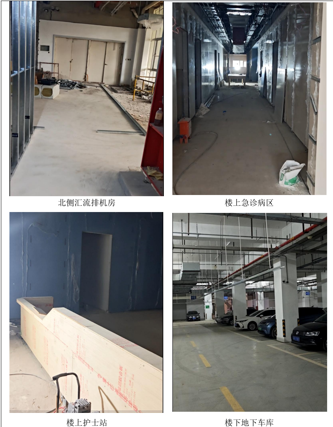
图 8-1 2 间 DSA 机房拟建址及周围环境现状图
